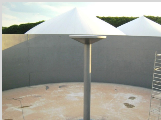
Epoxidharzbeschichtung bei einem Biogasbehälter
